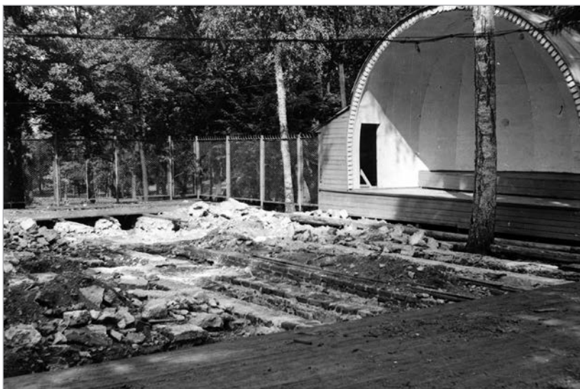
Проведение археологических раскопок для обнаружения фундамента Березового домика на месте танцевальной площадки 1970 Научный архив ГМЗ «Гатчина»
