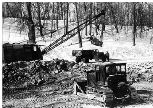
Нижний парк. Песочный пруд. Механизация работ по очистке пруда от ила 1963 ГМЗ «Петергоф»
