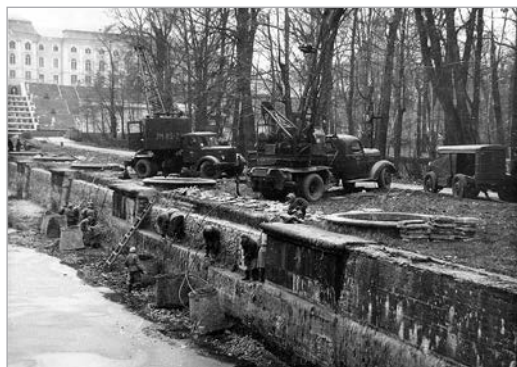
Нижний парк. Начало работ по реставрации гранитной облицовки стен Морского канала 1962 ГМЗ «Петергоф»
