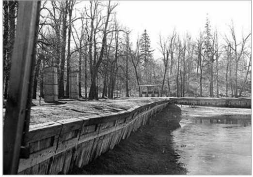
Нижний парк. Марлинский пруд. Состояние восточной стенки шпунтового ряда до реставрации 1962 ГМЗ «Петергоф»
