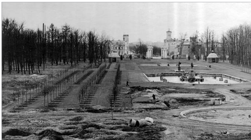
Петродворец. Верхний парк. Реставрационные работы Фотография З.П. Гуриненко. 1959 ГМЗ «Петергоф»
