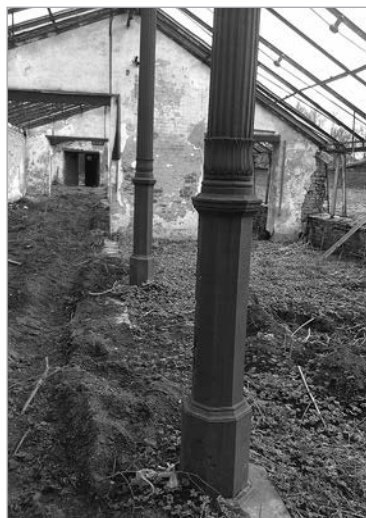
Чугунные опоры в здании на четвертой линии первого отделения Фотография А. Ю. Поляковой. 2015 ГМЗ «Гатчина»
