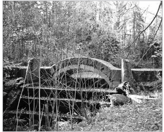
Восстановленная гранитная плотина-мостик восточного ручья Фотография Д. В. Осипова. 2006
