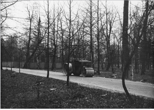
Капитальный ремонт Березовой аллеи. Укатка аллеи на участке между Львиным каскадом и Черным спуском 1962 ГМЗ «Петергоф»
