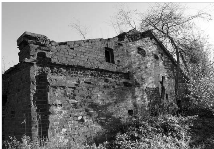
Фасад оранжереи в усадьбе Мордвиновых Фотография Н. Б. Ермиловой. 2011
